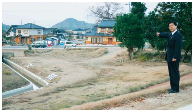
修復された出石川堤防と被災地域
